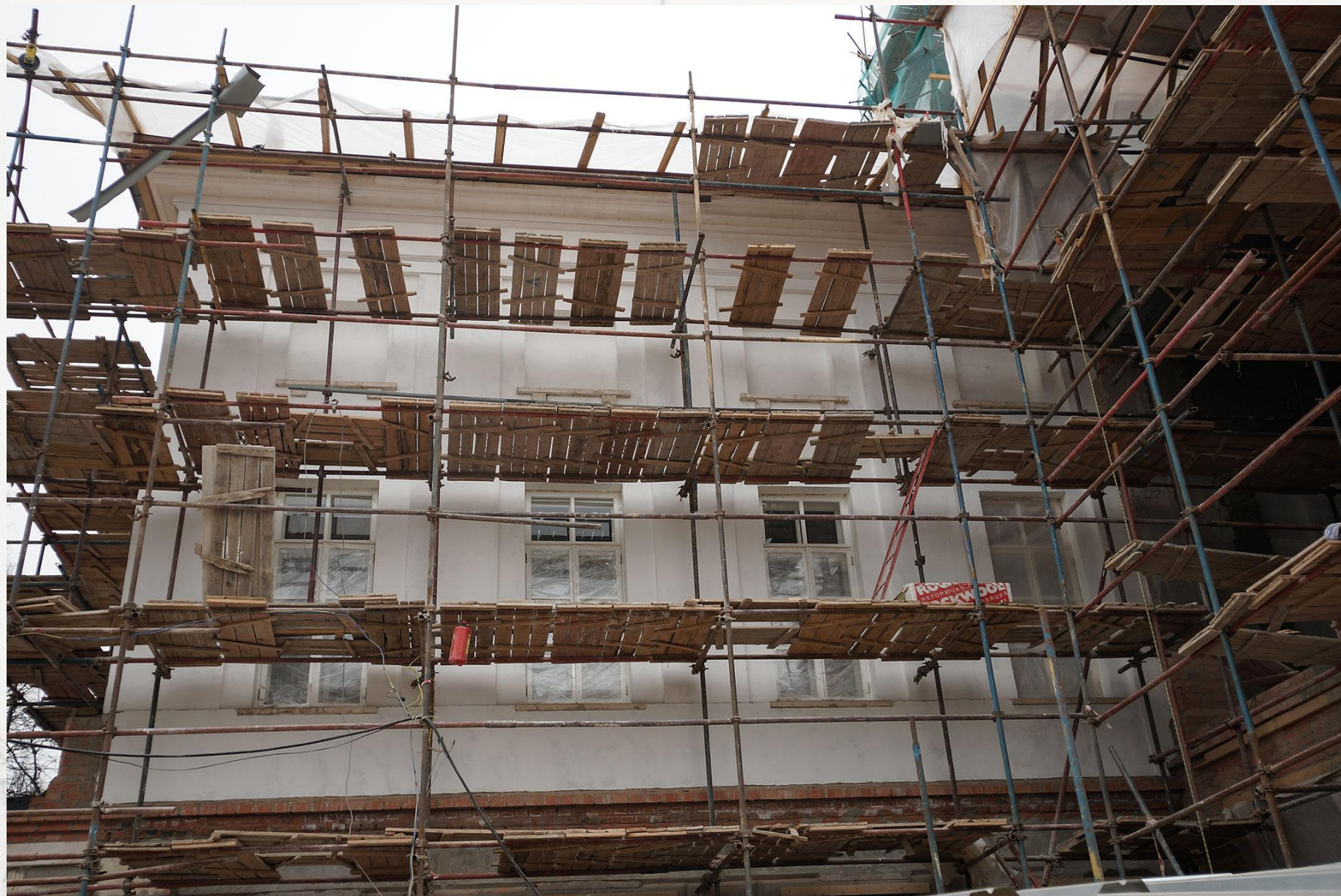
Шпатлевка фасада здания
