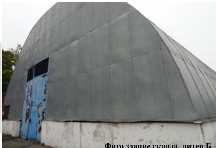
Фото здание склада, литер Б
