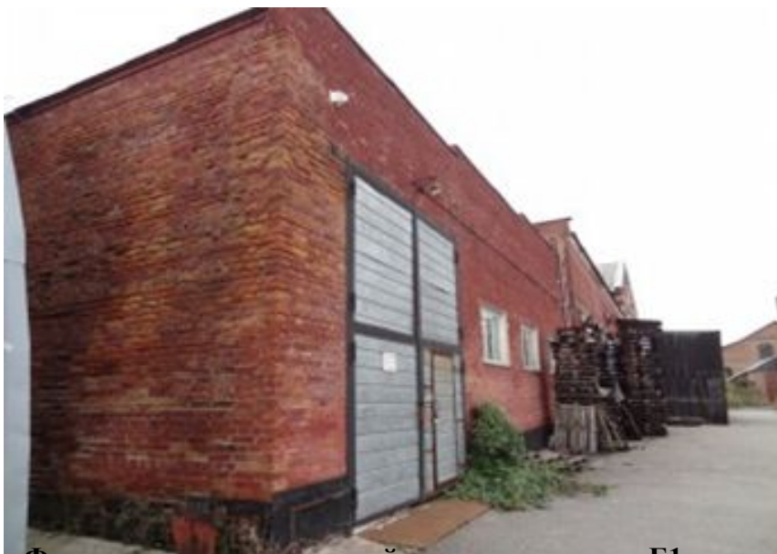
Фото здания склада готовой продукции, литер Б1
