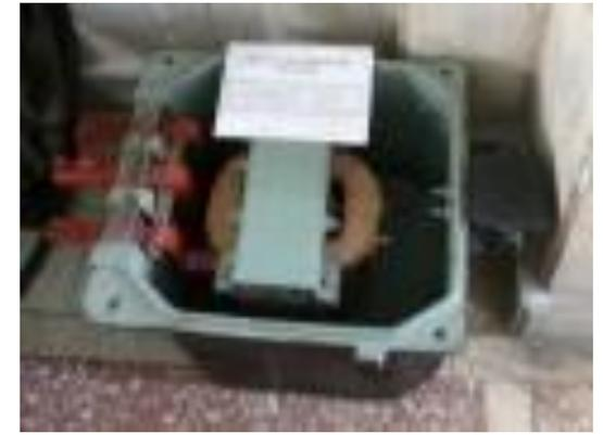
**Дроссель-трансформатор** — устройство для пропуска тягового тока из одной [рельсовой цепи](#) — устройство для пропуска тягового тока из одной рельсовой цепи в другую в обход [изолирующих стыков](#) — устройство для пропуска тягового тока из одной рельсовой цепи в другую в обход изолирующих стыков на электрифицированных линиях с [автоматической блокировкой](#).
